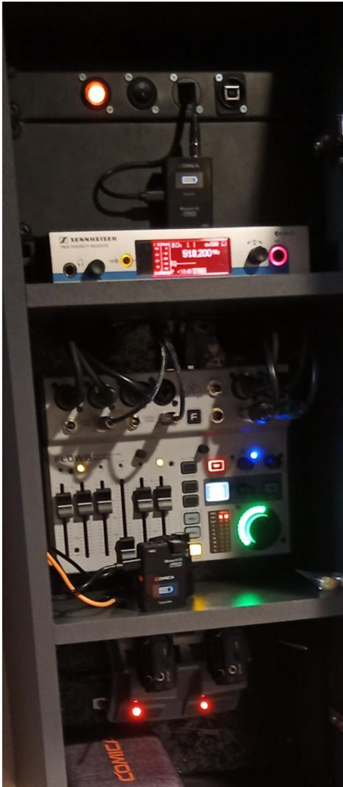
Der Beleuchtete Schalter schaltet das Pult, Empfänger und die Ladegeräte ein.
